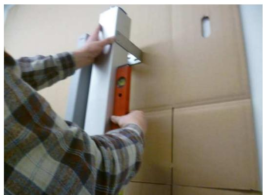
Nachdem der Winkel angeschraubt ist, ist die Pylone aufzustellen und auszurichten (rechts/links und vor/zurück). Im Lot stehend ist sie mit den mitgelieferten Bohrschrauben am Winkel befestigt; jeweils zwei Schrauben innen und außen.
