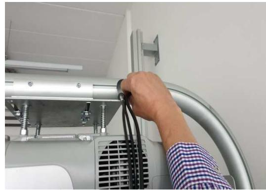
Montierter Beamer am Galgen, dessen Loch mit der im Lieferumfang enthaltenen Kunststoffkappe
