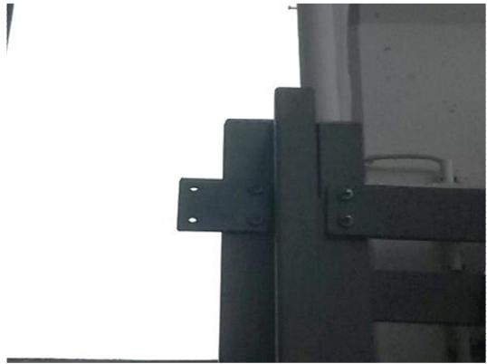
Vor dem Befestigen der vorderen Pylone durch wiederum zwei Bohrschrauben, sollte nochmals das Lot geprüft werden.
